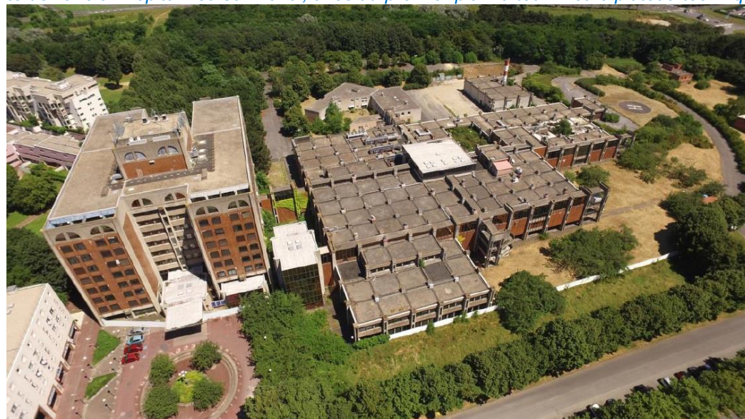
Site de l'ancien hôpital Louise Michel, avec au premier plan la tour H et le plateau technique
