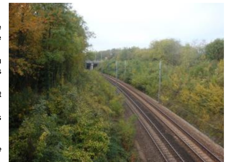
Talus SNCF dans le secteur d'étude
